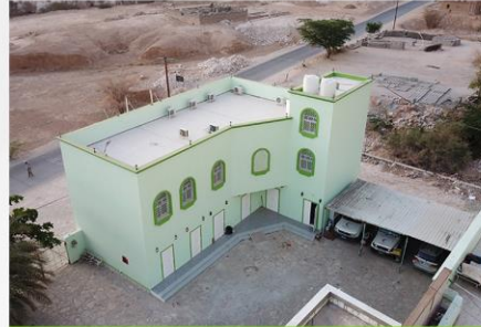
بناء تأثيث المبنى الجديد بالمستشفى الذي يضم الإدارة العامة وعيادات المخيمات والصيدلية
